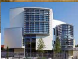
Conservatoire de musique et danse Maurice Ravel de Villemomble Constructeur métallique : Ateliers Mondevilais de Constructions Métalliques (Mondeville - 14)
