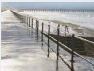
Digue de Luc-Sur-Mer Constructeur métallique : FRAMEIO (Carpiquet - 14)
