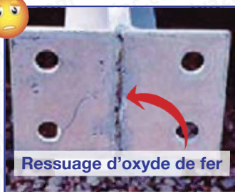
Photos 35 et 36 : Conséquences d'intervalles étroits
