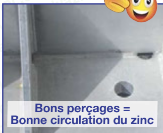
Photos 29 et 30 : Grugeages et perçages
