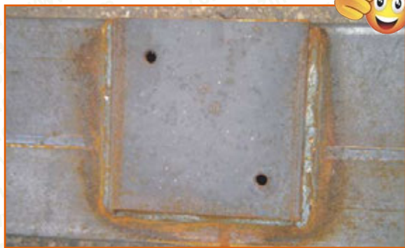
Photo 50 : Trous d'évent et soudure continue
