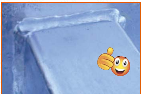
Photo 51 : Exemple de revêtement de galvanisation homogène d'une soudure continue
