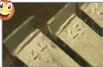
Photo 59 : Cordon de soudure
